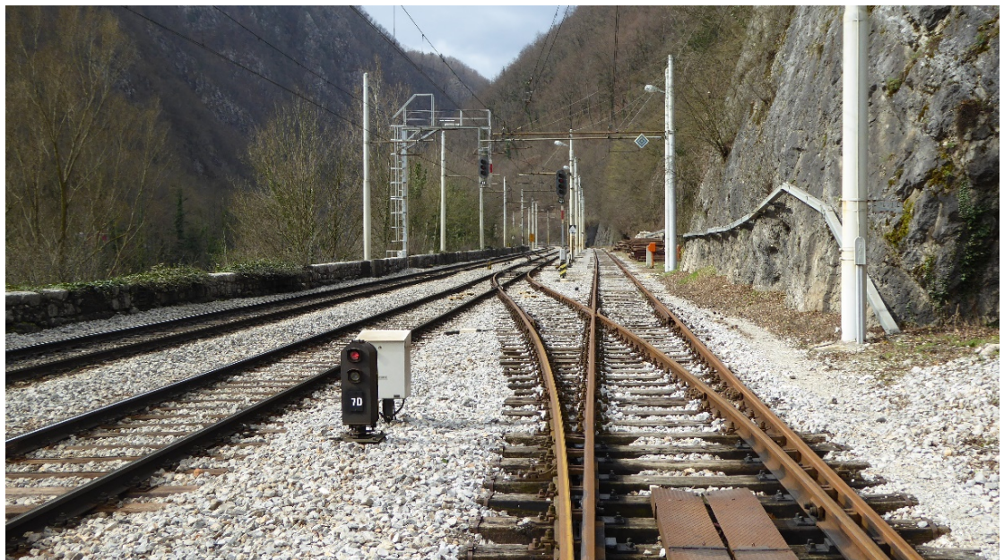
Slika 7: Desna skalnata brežina na zaključku postajnega odseka Zagorje.
